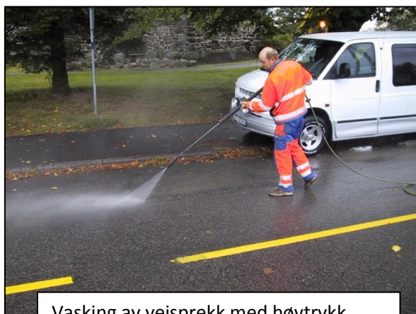
Vasking av veisprekk med høytrykk
