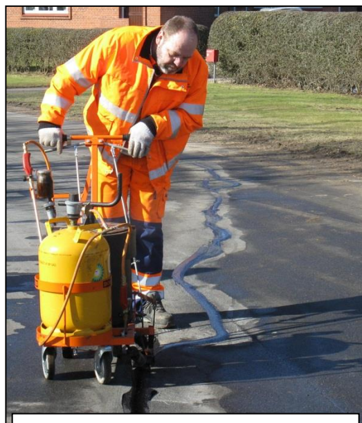
Fuging med fugeutlegger og slepesko.
